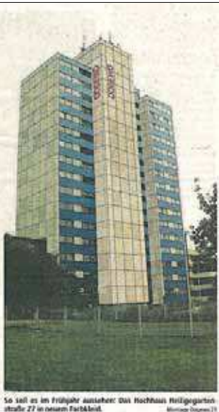
So soll es im Frühjahr aussehen: Das Hochhaus Heiligegartenstraße 27 in neuem Farbkleid.
